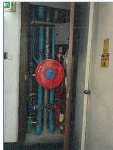
ภาพถ่ายที่ 2.2-8 ตู้ดับเพลิง (Fire Hose Cabinet)
