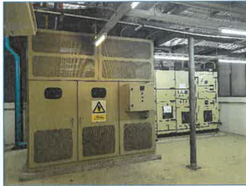
หม้อแปลงไฟฟ้าและระบบควบคุมไฟฟ้า MDB
