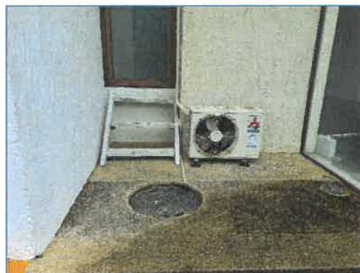
บ่อพักน้ำทิ้งก่อนเข้าระบบบำบัดน้ำเสียรวม
