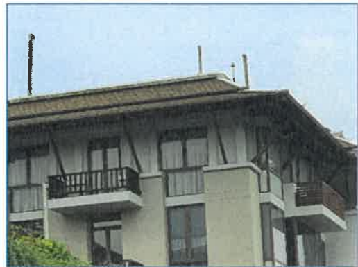
ภาพถ่ายที่ 2.2-14 เสาหล่อฟ้า สายหล่อฟ้า
